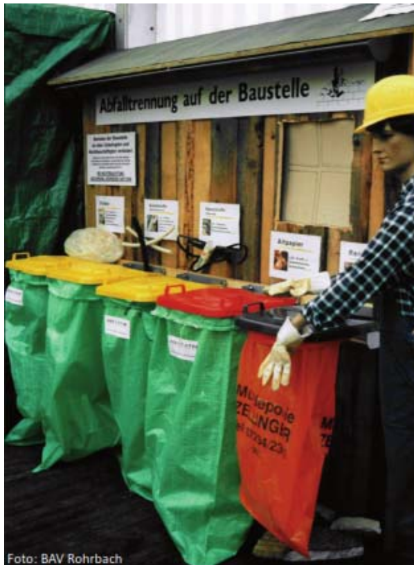
Foto: BAV Rohrbach
