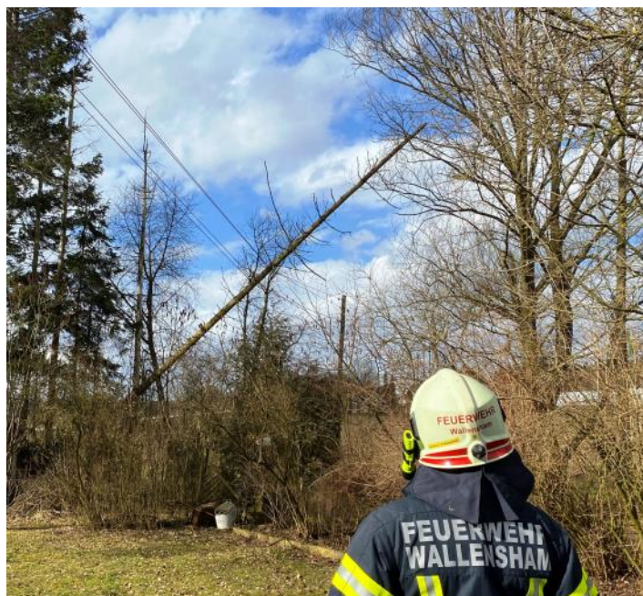
Baum in Stromleitung
