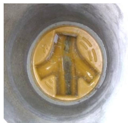
Abbildung 4: Flexliner - fertiger Einbau
